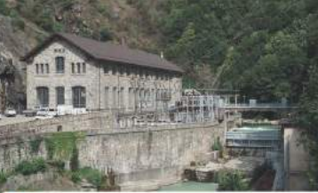
La centrale idroelettrica di Point-Saint-Martin.
