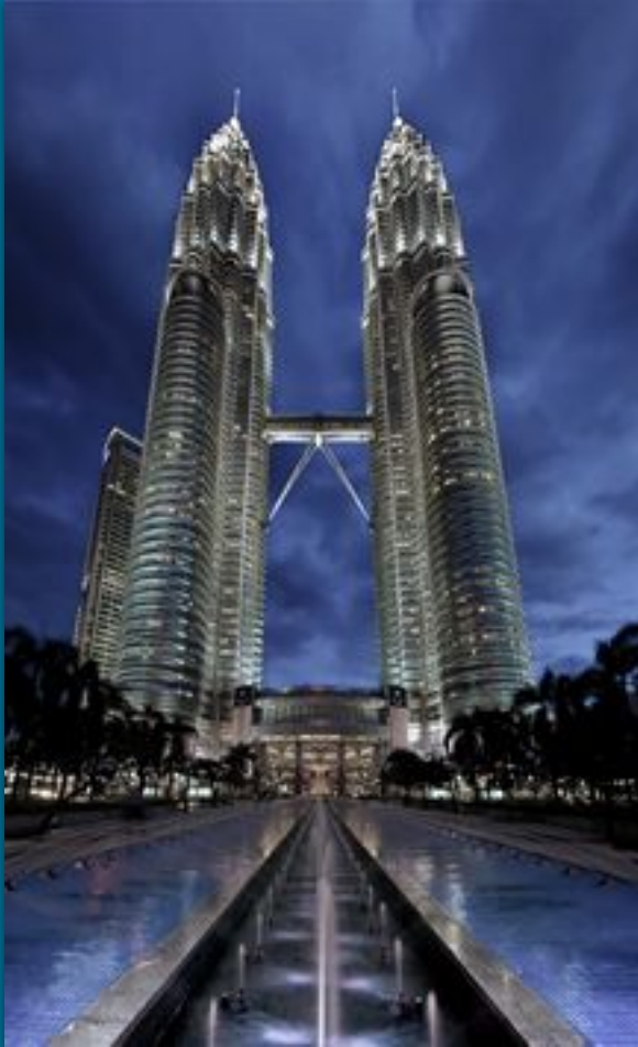
C. Pelli, Torri Petronas. Kuala Lumpur, 1999.
