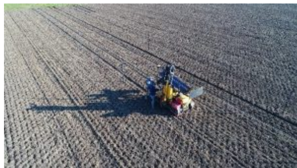
5. Posa in opera dei pali con sistema GPS.
