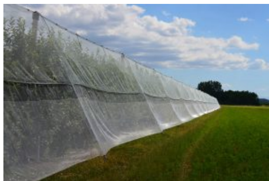
Fig. 24 Chiusura antinsetto laterale a mezzo reti
