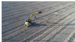
Interramento pali in legno
