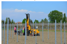
Interramento pali vigneto
